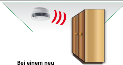
Bei einem neu aufgestellten Schrank wird der Mindestabstand unterschritten
